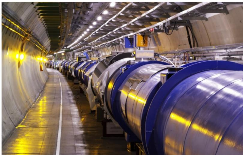
Рис. 6.19. Смонтированные криомагниты для поворота пучков ускоряемых протонов в туннеле БАК (Maximilien Brice, © CERN)
