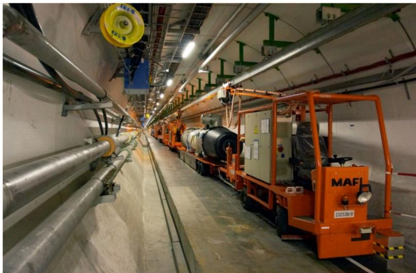
Рис. 6.18. 27-километровый подземный туннель, предназначенный для размещения ускорителя БАК. Туннель после демонтажа LEP
